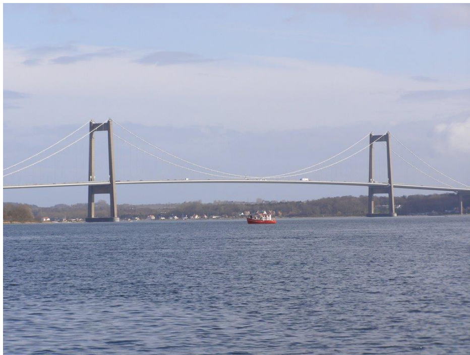
Slika 5: Most s poševnimi zategami.
