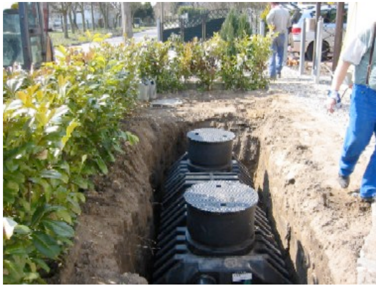
Slika 3: Mala čistilna naprava pred zasipom
